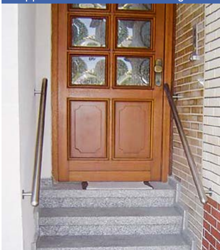
Treppe mit Handläufen beidseitig
