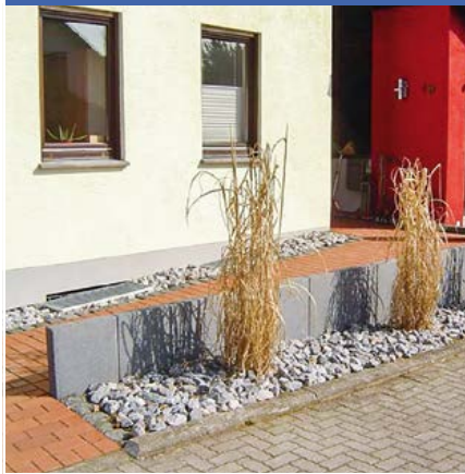
Hauseingang nachher: mit Rampe
