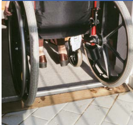
Schwellenbrett zum Ausgleich der Türschwelle
