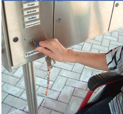
Niedrige Briefkästen und automatische Türöffnung per Schlüssel
