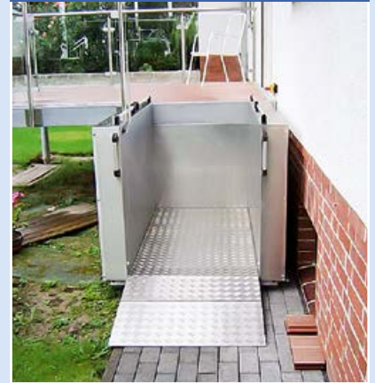
Zugang mit Plattformlift
