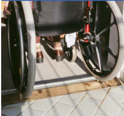
Schwellenbrett zum Ausgleich der Türschwelle
