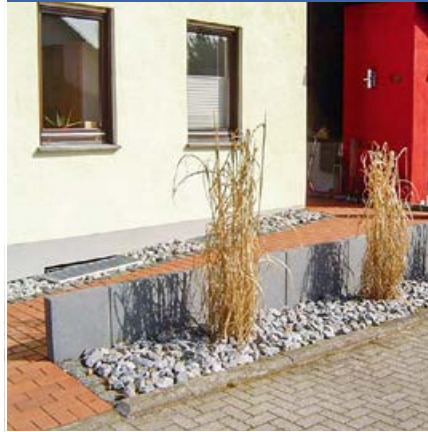
Hauseingang nachher: mit Rampe
