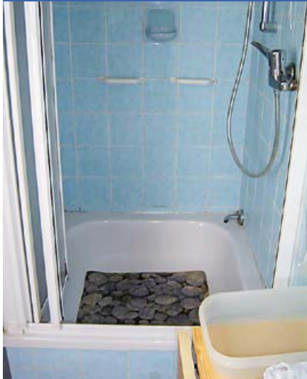
Dusche vorher: mit hohem Einstieg
