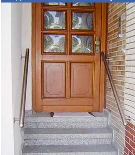
Treppe mit Handläufen beidseitig
